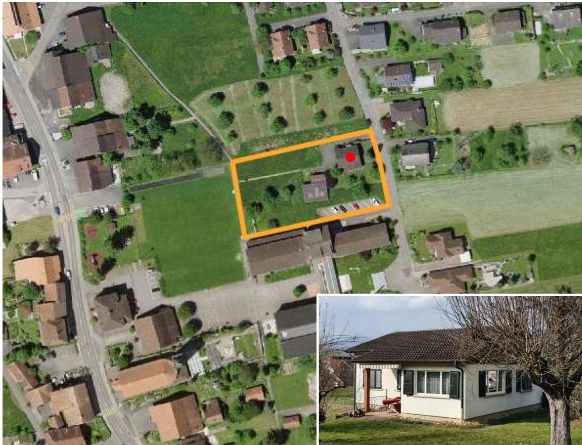
Abbildung 2 Luftbild, Parzelle Nr. 96 = gelb umrandet, roter Punkt = Wohngebäude (Quelle: GeoViewBL, abgerufen am 8. April 2022), Bild unten rechts: Wohngebäude (Quelle: Präsentation Traktanden Gemeindeversammlung 8. Dezember 2021)
