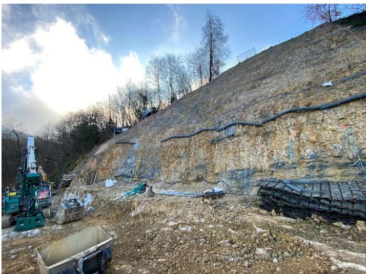
Beim Bahnübergang Bahnhofstrasse laufen weiterhin die Felsrückbauarbeiten. Der Felsrückbau erfolgt mit Lockerungssprengungen, welcher in Zugsphasen und unter Verkehrssperren ausgeführt wird.
